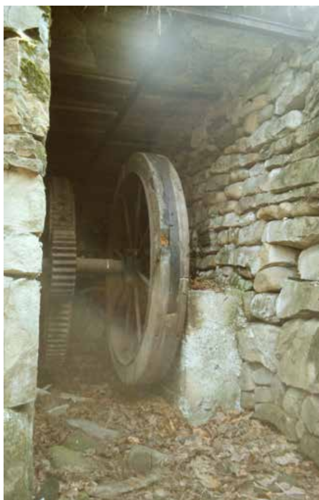
Ryc. Urządzenia wodne w tartaku wodnym nad brzegiem potoku Skawica Górna w Zawoi-Fujacy, fot. P. Krzywca, 1988.
